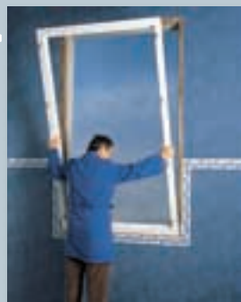
Pose du nouveau dormant
