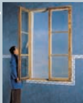
Dépose des anciens ouvrants
